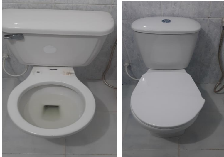
Cambio sanitario sala de profesores antes y después
