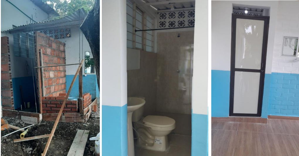
Construcción baño para guardas de seguridad antes y después
