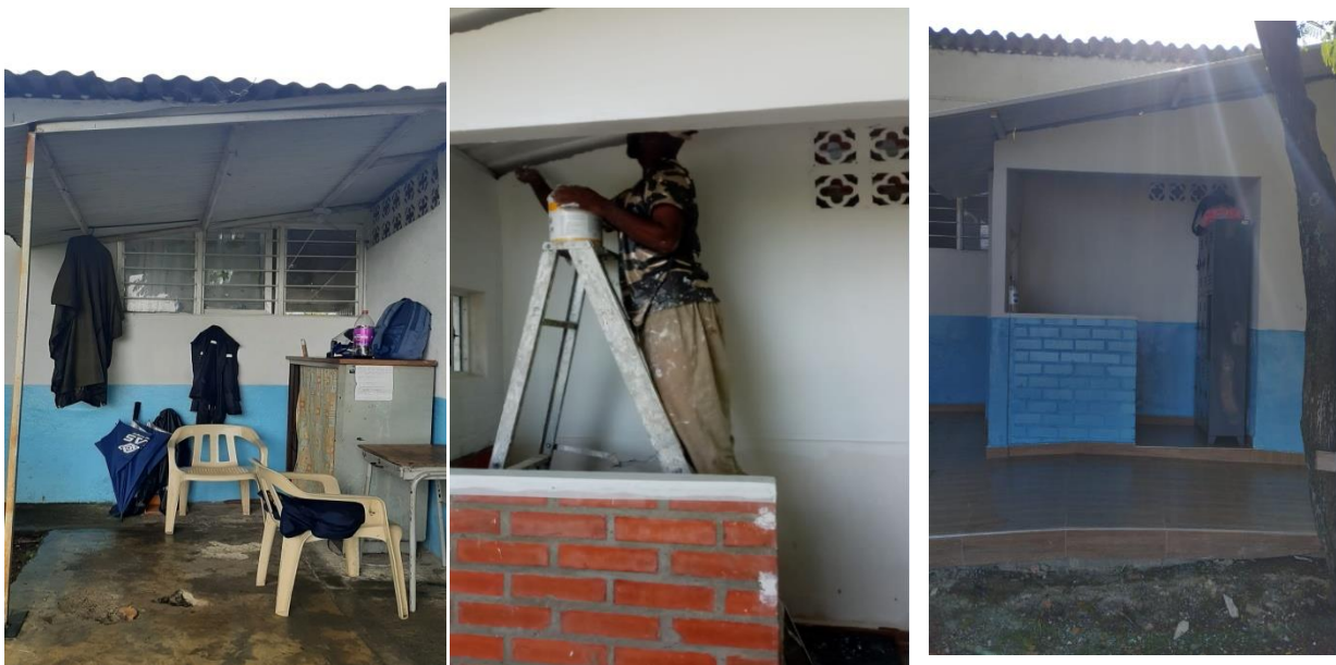
Construcción garita para guardas de seguridad antes y después
